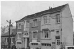
Rue de la Parmentière, immeuble années 40
